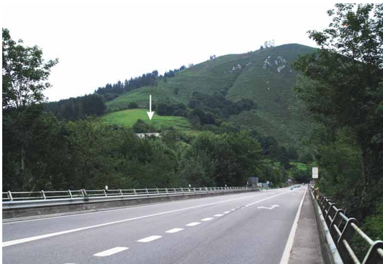
Fig. 11. El Monte Cayón, señalando la flecha una de las zonas posibles de localización del ignoto dolmen de Migoya. La carretera Oviedo-Santander gira a la derecha, al fondo, para seguir el tramo angosto del Piloña, antes de acceder a la mayor amplitud de su valle en el área de Infiesto. (M. Á. de B).
