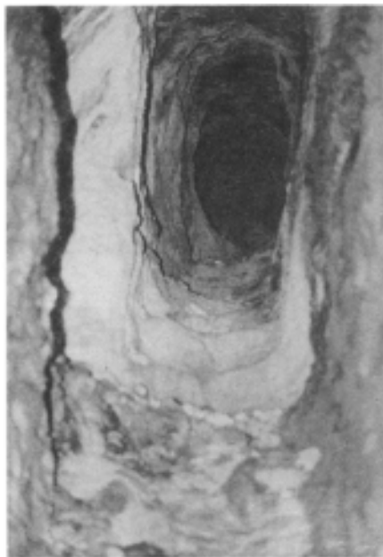
Foto 2. Galería n.º 3 zona en rampa.
