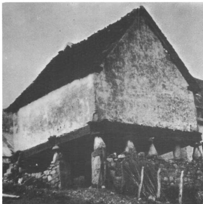
Fig. 1. Hórreo de la Aezkoa (Navarra).
